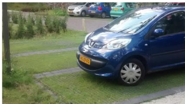
PARKEREN OP GRASBETONSTENEN
